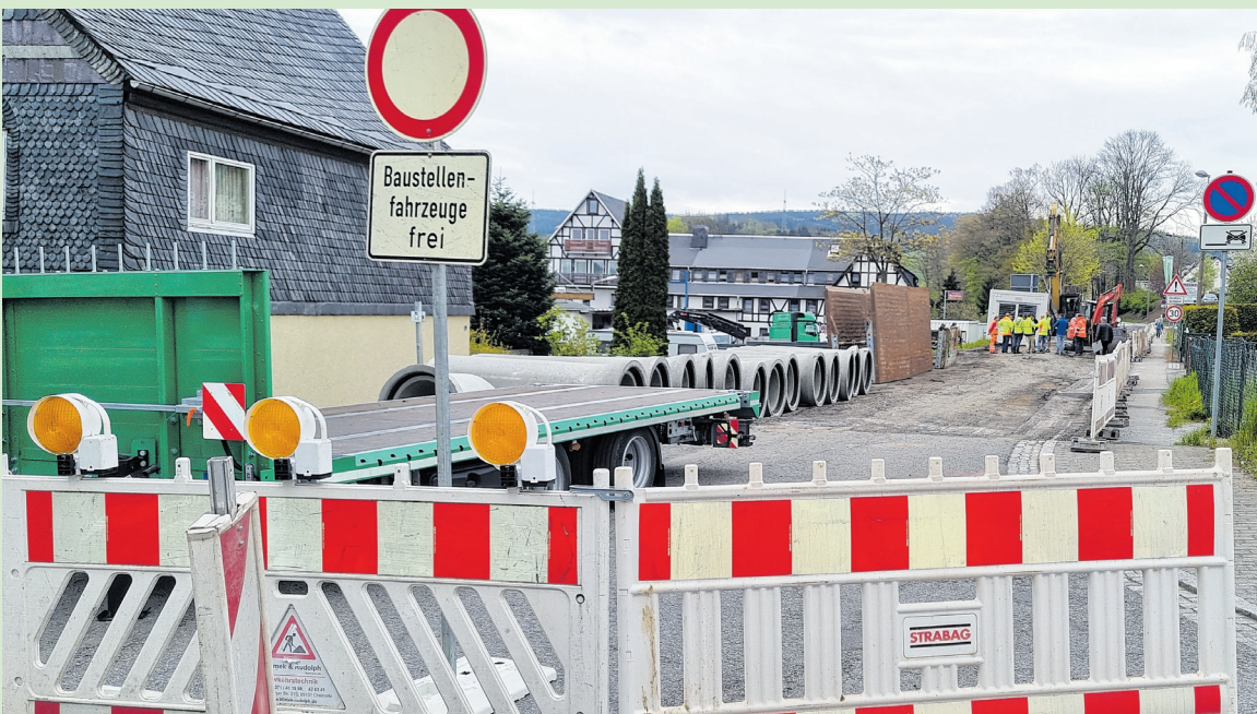
Baubeginn der Annaberger Straße in Zwönitz am 8.5.2023
