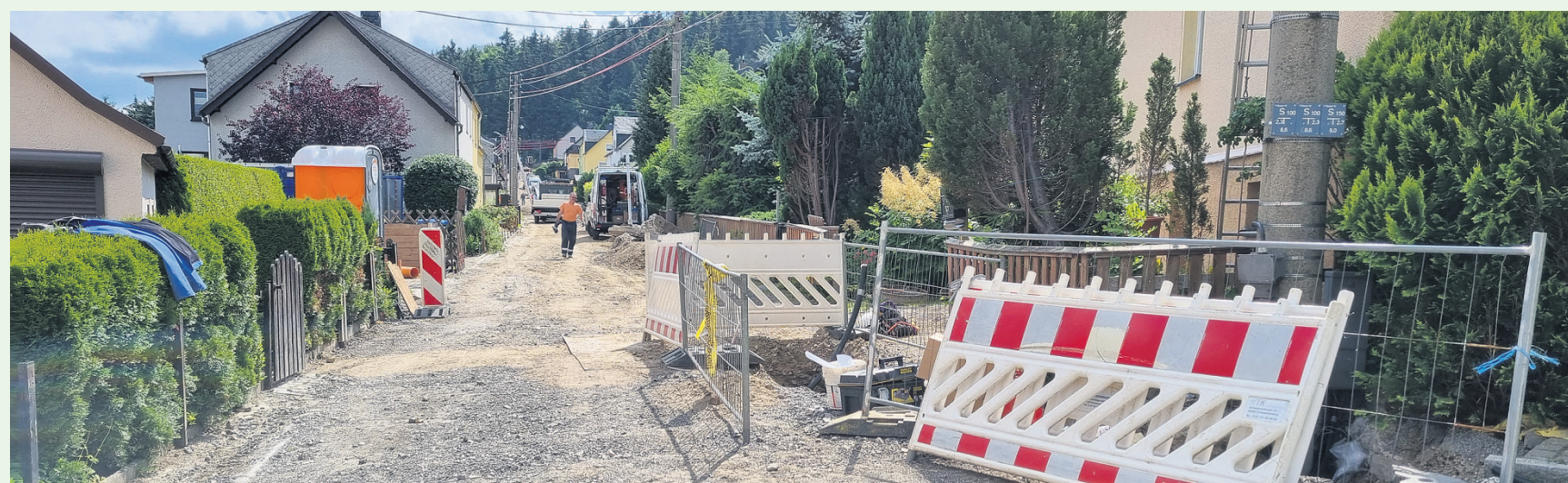
Hier in der Albrecht-Straube-Siedlung in Grünhain-Beierfeld ist die Baufertigstellung zum 28.10.2022 geplant.
