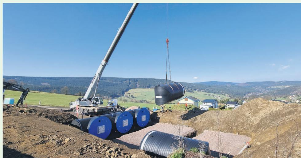
In Breitenbrunn bauen die Wasserwerke West erzgebirge derzeit einen neuen Hochbehälter. Der neue Hochbehälter entsteht direkt neben seinem Vorgänger und fasst 300 Kubikmeter Trinkwasser. Mit Inbetriebnahme löst dieser dann zwei alte Anlagen ab, den Hochbehälter an der Schachtstraße (300 m<sup>3</sup> Fassungsvermögen) sowie den Hochbehälter an der Halbemeiler Straße (50 m<sup>3</sup> Fassungsvermögen). Die Gesamtkosten des neuen Bauwerkes in Breitenbrunn liegen bei 736.000 Euro.
