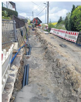
Im Trinkwassersystem werden insgesamt 660 Meter Leitung in der Paul-Schneider Straße erneuert. Zwischen Hausnummer 4 bis 20 wurde im Monat Mai bereits eine neue Leitung der Dimension DN90 verlegt.
