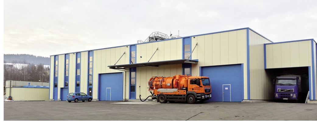
In diesem Gebäude auf dem Gelände der Kläranlage Schwarzenberg befinden sich die Schlammwässerung und die Mikrogasturbinen.
