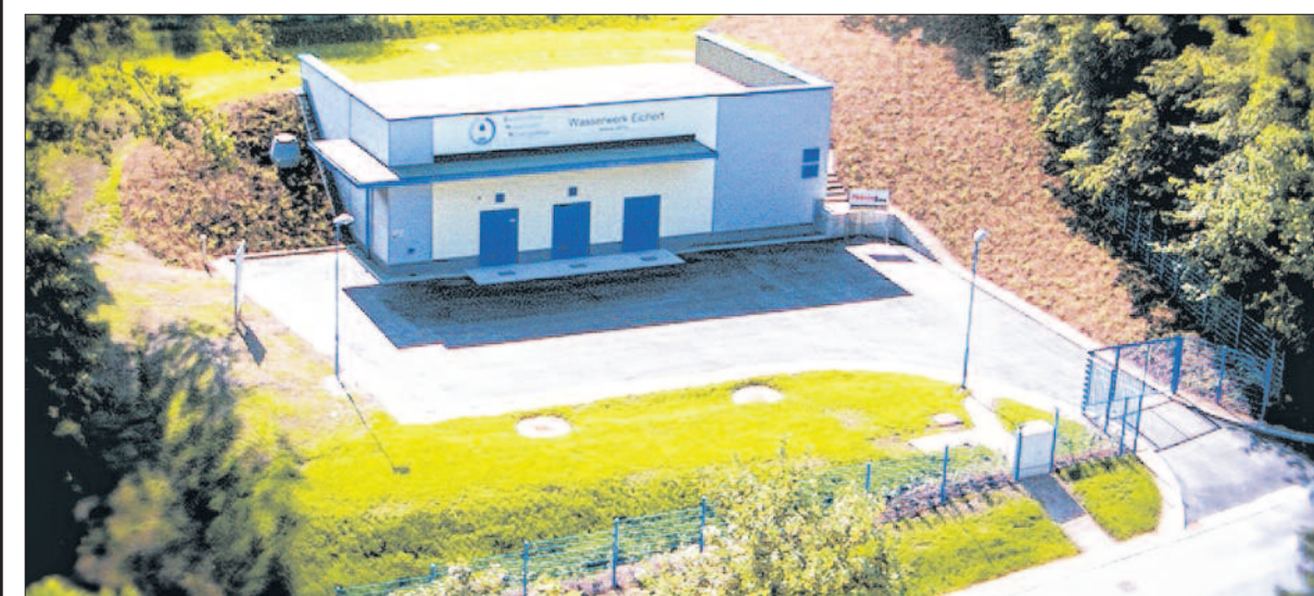
Das neue Wasserwerk in Aue auf dem Eichert kurz nach der Fertigstellung im Juni 2013.
