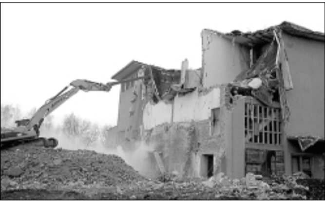
Der Abriss des Wasserwerkes erfolgte von Oktober bis Dezember 2009. Das gesamte Areal wurde renaturiert.
